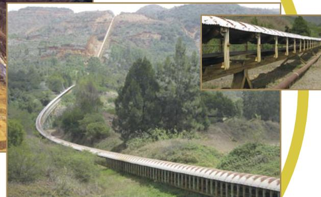
Le convoyeur achemine le minerai vers le littoral où il est chargé sur un minéralier qui le transporte vers l'usine de traitement.
